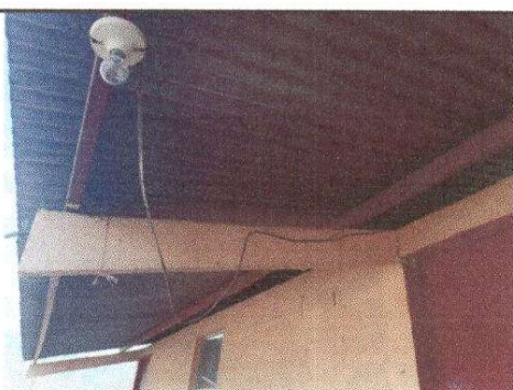
Foto 5: Reparación de Sistema Eléctrico
