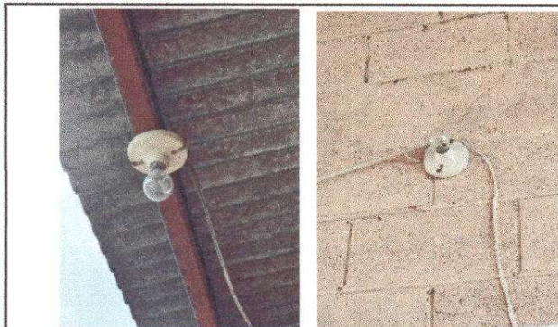
Foto1: Sustitución de focos ahorradores y plafoneras
