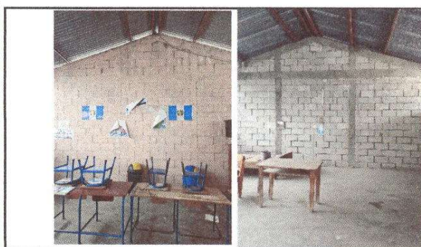
Foto 5: Pintura en muros exteriores e interiores
