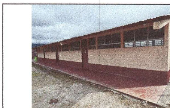
Foto 6: Pintura en muros exteriores e interiores
