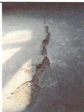
Foto 3: Sustrucción de piso cemento liquido por piso ceramico
