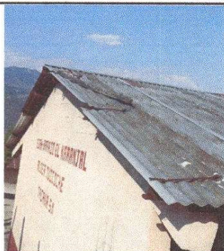
Foto 1: Sustrucción de lámina, por lámina troquelada aluzinc calibre 26
