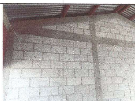
Foto 6: Reparación de Sistema Eléctrico
