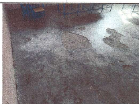
Foto 4: Sustrucción de piso cemento liquido por piso ceramico
